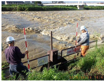
状況把握員等による現地踏査
